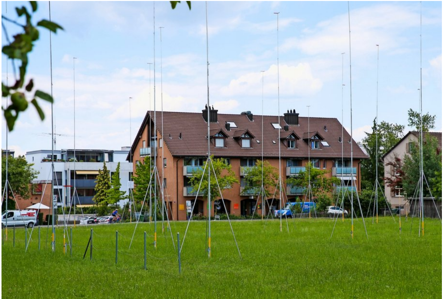
Blick von der Schneckenwiese auf die Breitstrasse, an der künftig das Haus Nord mit der Bibliothek zu stehen kommt.
