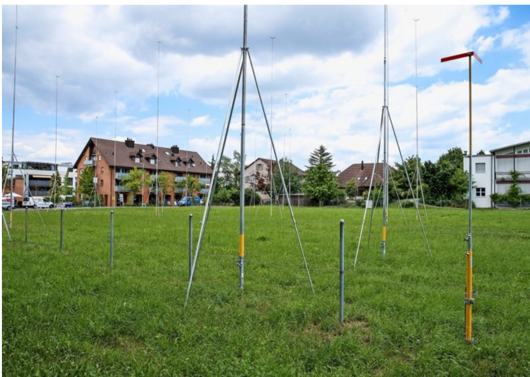
Die Baugespanne zeigen die Dimensionen des Projekts auf der Seuzacher Schneckenwiese auf.
