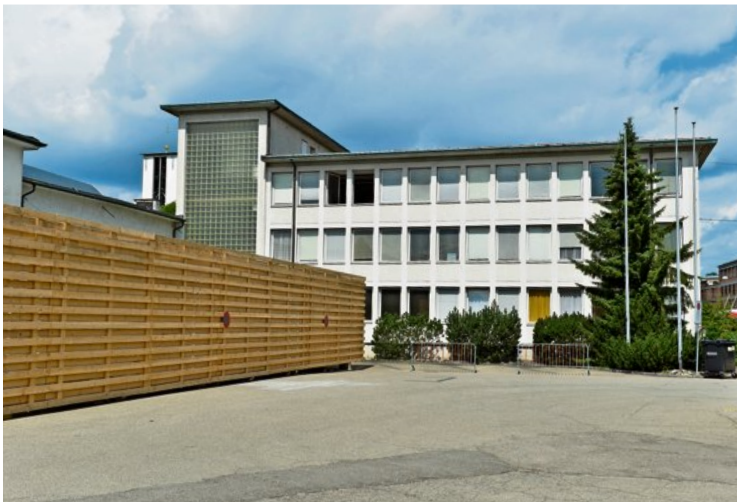
Der Bürobau bleibt stehen, die Schutzverfügung wird bald publiziert. Die Holzwand schützt die Asylsuchenden im Depot vor neugierigen Blicken. Donato Caspari
